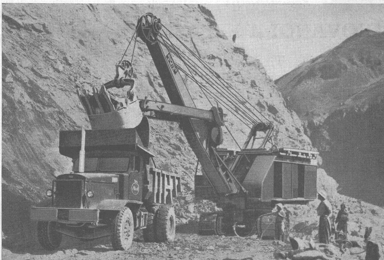
Excavateur BUCYRUS-ERIE 54 B à commande électrique Ward Leonard 1900 1 avec camion-basculeur MACK LR 7,5 - 10 m 3 , 275 CV, sur le chantier de la Grande Dixence. Vente exclusive pour la Suisse : Robert Aebi & Cie S. A., Uraniatr. 31, Zurich.
