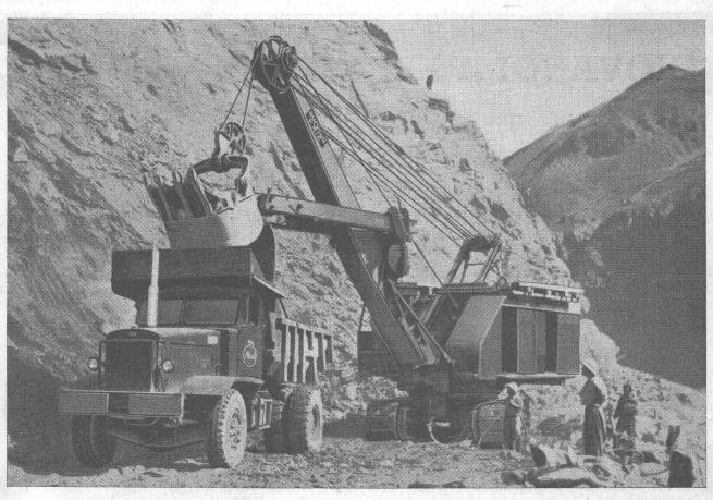
Excavateur BUCYRUS-ERIE 54B à commande électrique Ward Leonard 1900 l avec camion-basculeur MACK LR 7,5 - 10 m³, 275 CV, sur le chantier de la Grande Dixence.
