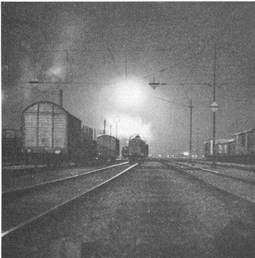
Fig. 3. — Eclairage au centre du faisceau de triage.
