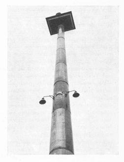
Fig. 13. — Tour  $n^{o}$  I, fenêtre pratiquée à 13 m du sol et armatures mobiles de 500 W.
