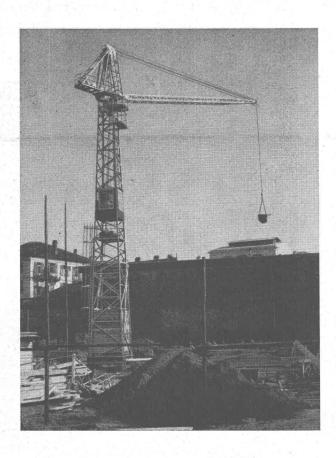
La Forme 10 a été conçue pour répondre aux désirs fréquents de la clientèle d'utiliser une grue moyenne pouvant être montée et transportée aussi rapidement qu'une petite grue. Elle est aussi livrable avec le bras mobile sous charge et se monte en quelques heures sans accessoires. Elle peut être commandée simultanément depuis le bas et dans la cabine. Son rendement comme ses différentes portées en font une machine idéale.
