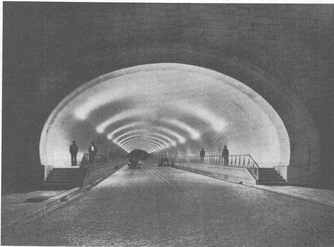
Route de Marginal à Porto (Portugal) Enduit étanche au SIKa, joints au mastic IGAS
