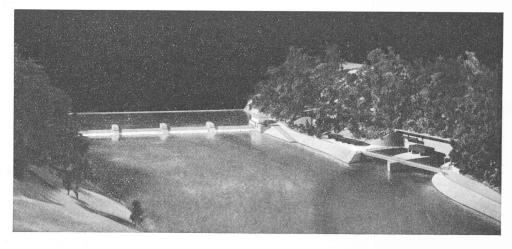
Fig. 7. — Maquette du barrage auxiliaire inférieur, et, à droite, des galeries et canaux de restitution dans le Rhin de l'eau utilisée par les turbines. Vue de l'aval vers l'amont.
