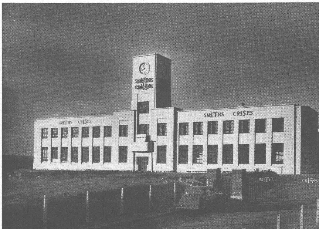
Smith's Crisps Factory, à Bristol (Angleterre). Etanchéité au SIKA, joints étanches à l'IGAS.
