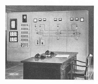
Fig. 12. — Poste de commande pour 50 ordres de l'installation de télécommande de Düshorn (Allemagne).
