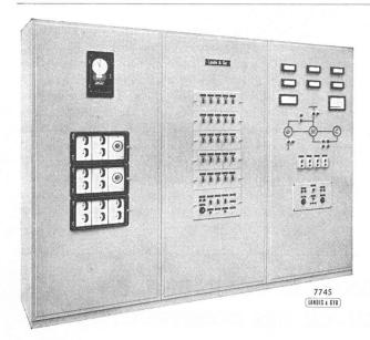
Fig. 14. — Tableau d'émission de l'installation de télécommande de Bruxelles (Belgique).
