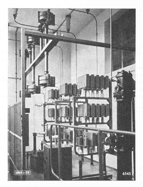
Fig. 15. — Filtre de couplage de l'installation de télécommande de Locarno (Suisse). Injection en parallèle sur haute tension 50 kV.
