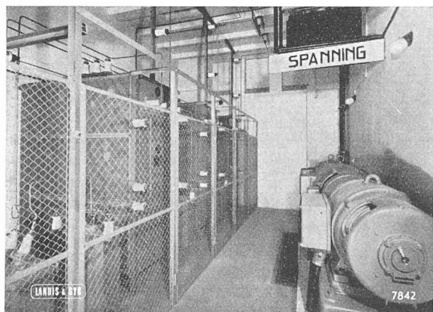
Fig. 16. — Groupe convertisseur de l'installation de télécommande des GEB Dordrecht (Hollande) avec ses 400 doubles-commandes. (Portées plus tard à 600.)
