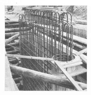
Fig. 22. — Ferraillage d'une palée.
