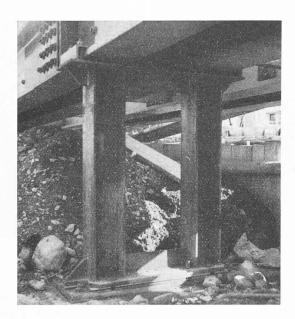
Fig. 17. — Appui du pont provisoire.
