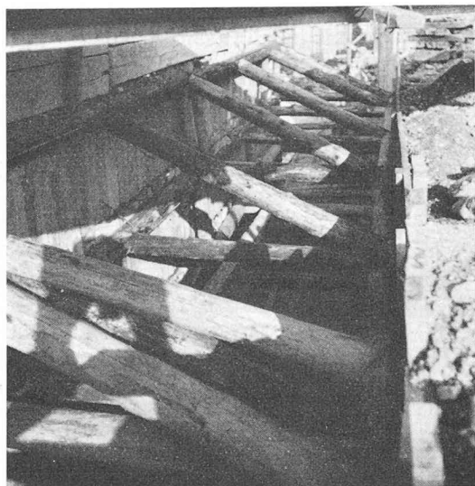
Fig. 14. — Boisage de la fouille d'une des culées.
