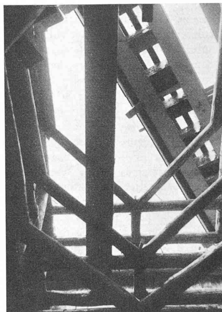
Fig. 15. — Boisage de la fouille d'une palée, sous le pont provisoire.
