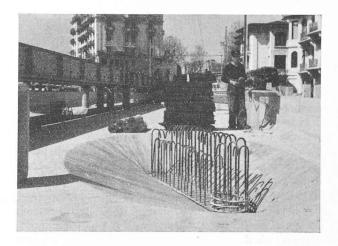
Fig. 23. - Coffrage du tablier ; détail d'un gousset elliptique.
