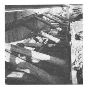
Fig. 14. — Boisage de la fouille d'une des culées.
