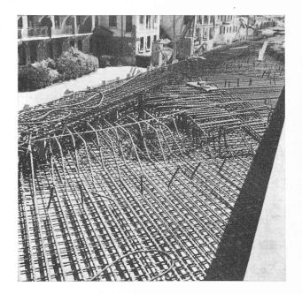
Fig. 24. — Détail de ferraillage de la dalle près d'une palée. Seule la nappe inférieure est posée.
