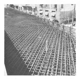
Fig. 25. — Ferraillage général de la dalle.
