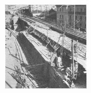
Fig. 26. — Le bétonnage de la dalle.
