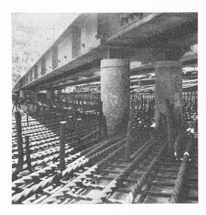
Fig. 18. — Ferraillage sous le pont provisoire, avec protection des béquilles par des tuyaux d'éternit.
