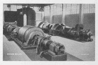
Fig. 12. — Turbine à gaz de 10 000 kW ayant fonctionné depuis sa mise en marche en 1951 pendant plus de 10 000 h à la charge moyenne de 7500 kW avec un rendement thermique industriel moyen de 23,6 %.
