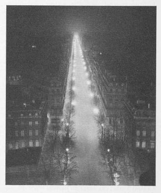
Fig. 14. — Avenue Victor-Hugo éclairée par fluorescence, sauf aux abords de la place de l'Etoile où subsiste encore l'incandescence (bas de la photo).
