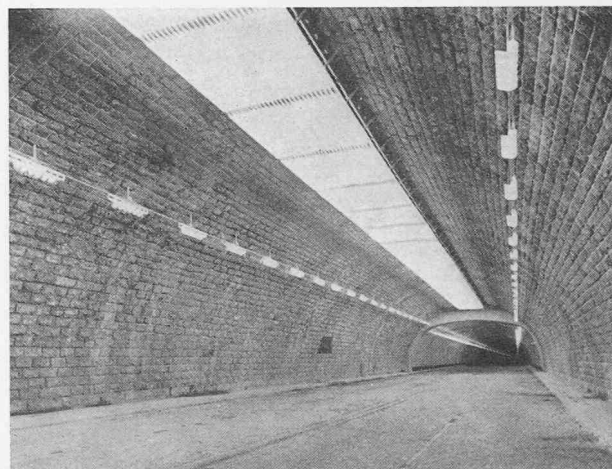
Fig. 17. — Entrée du tunnel routier de la Croix-Rousse, à Lyon. Sur les côtés, appareils à lampes 40 watts basse tension. Au plafond, 26 lignes de tubes haute tension.
