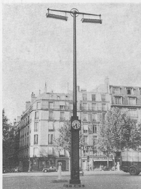
Fig. 5. — Candélabre double (avenue de la Grande-Armée). 2 appareils à 4 lampes Sylvania de 100 watts, 1,50 m.
