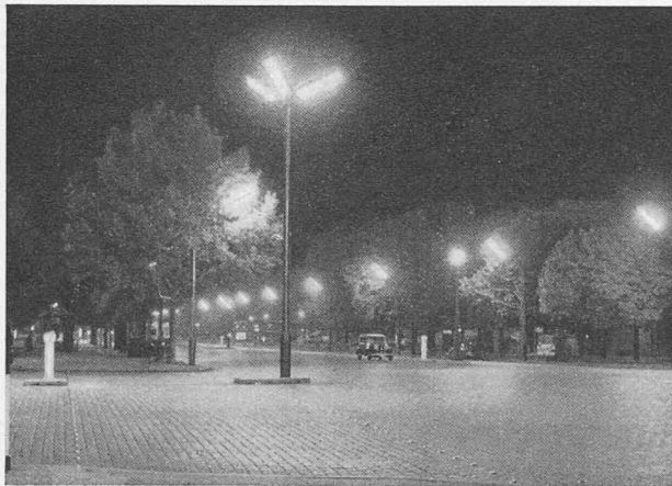
Fig. 9. — Carrefour Vincennes-Pyrénées. Candélabre à trois branches. Appareils Neuhaus à 4 lampes Sylvania 100 watts.
