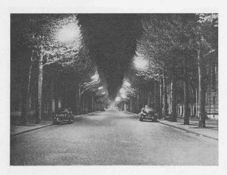
Photo Neuhaus. Fig. 12. — Avenue Victor-Hugo (Paris) éclairée par appareils Neuhaus à 3 lampes Visseaux 40 watts. Flux par appareil: 7500 lumens.
