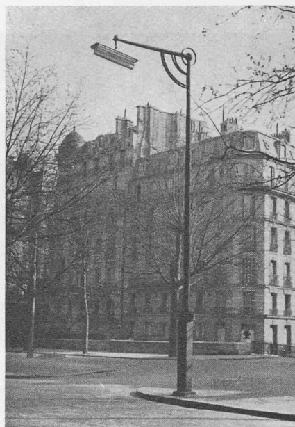
Photo M. Gaymard. Fig. 10. — Avenue du Président-Wilson (Paris). Appareil Philips à 3 lampes de 40 watts.
