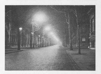
Fig. 11. — Avenue du Président-Wilson éclairée par appareils Philips à 3 lampes de 40 watts.
