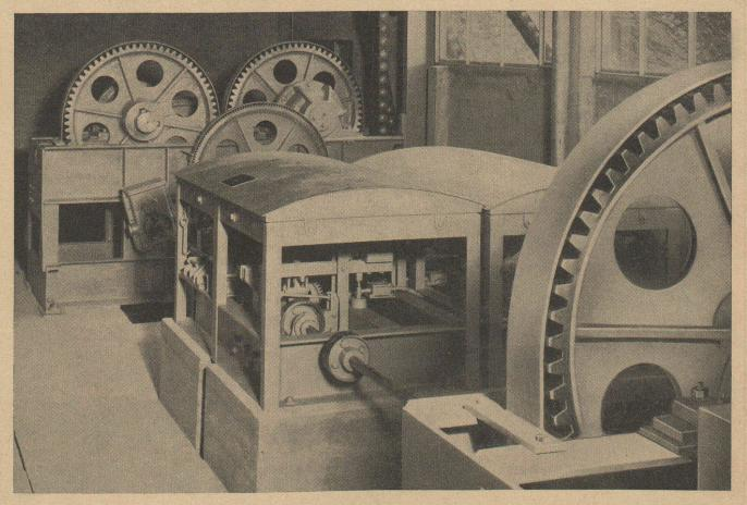
Mécanisme de vanne de grande puissance exécuté par les Ateliers de Constructions Mécaniques de Vevey S. A. Voir page 204 du présent numéro.
