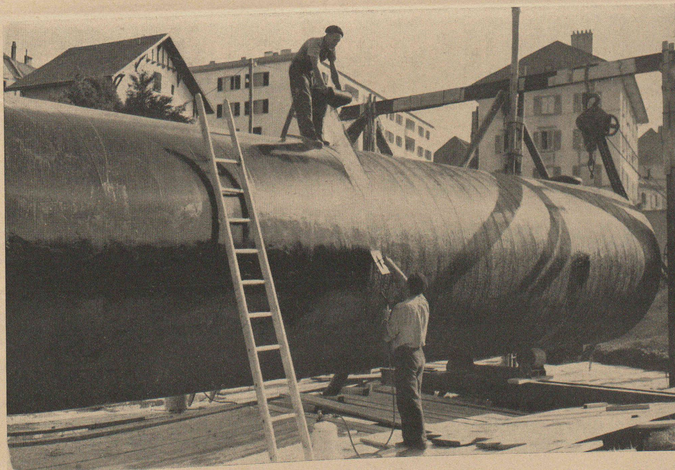
Isolation Waberit avec tissus de verre imputrescible « VETROTEX-ARMATURE » d'une citerne à mazout pour les Services industriels du Locle.
