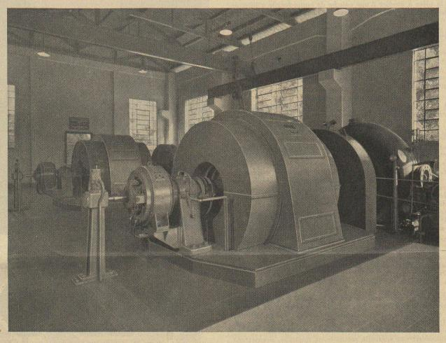
2 alternateurs triphasés à axe horizontal de 2860 kVA, 1200 t/min, 3300 V, 60 Hz livrés pour la centrale de Londrina au Brésil.
