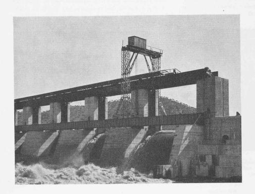
Fig. 31. — Aile gauche du barrage. Ouverture de deux vannes: panneau supérieur entièrement abaissé, panneau inférieur relevé de 1 m. Débit par pertuis: 470 m³/sec. On aperçoit encore l'un des deux portiques qui ont servi au montage des vannes.
