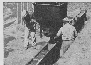
On coule le béton dans les éléments de coffrage.
