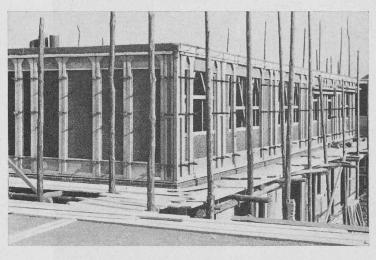
Construction monolithe « Korrelbeton » (Béton coffré). Un béton poreux est coulé dans des coffrages normalisés d'une hauteur égale à la hauteur d'étage et d'une largeur obéissant à un système modulaire de 10 cm.
