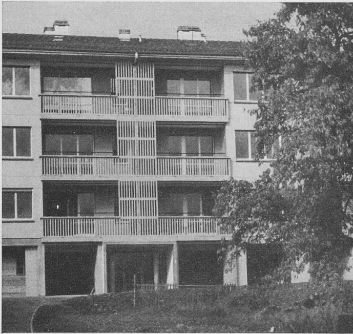
Fig. 61. — Immeuble à l'avenue C.-F. Ramuz, à Pully, façade sud.
