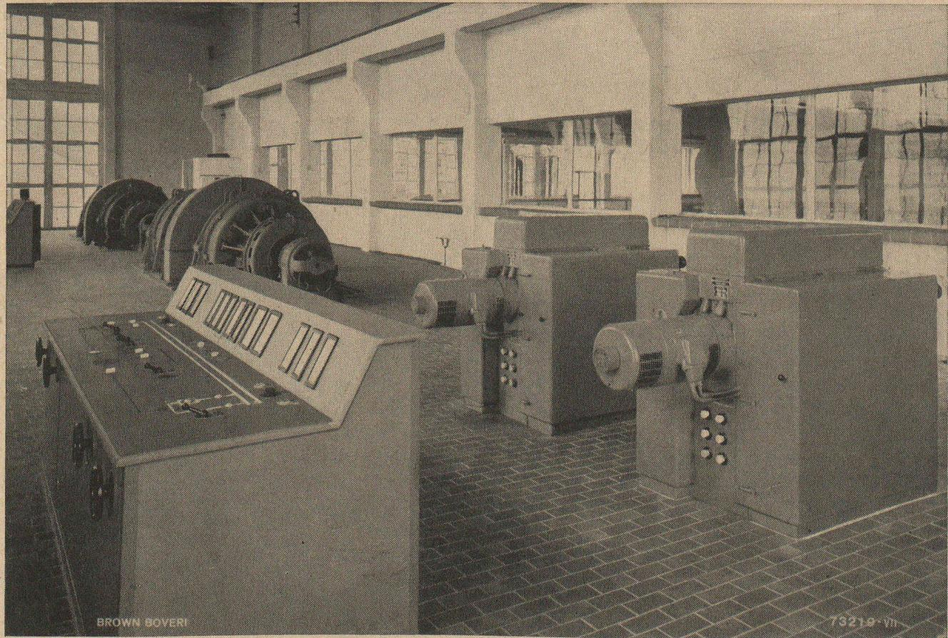
Convertisseurs à contacts Brown Boveri installés dans une usine chimique et pouvant débiter chacun 5000 A sous 150 à 230 V
