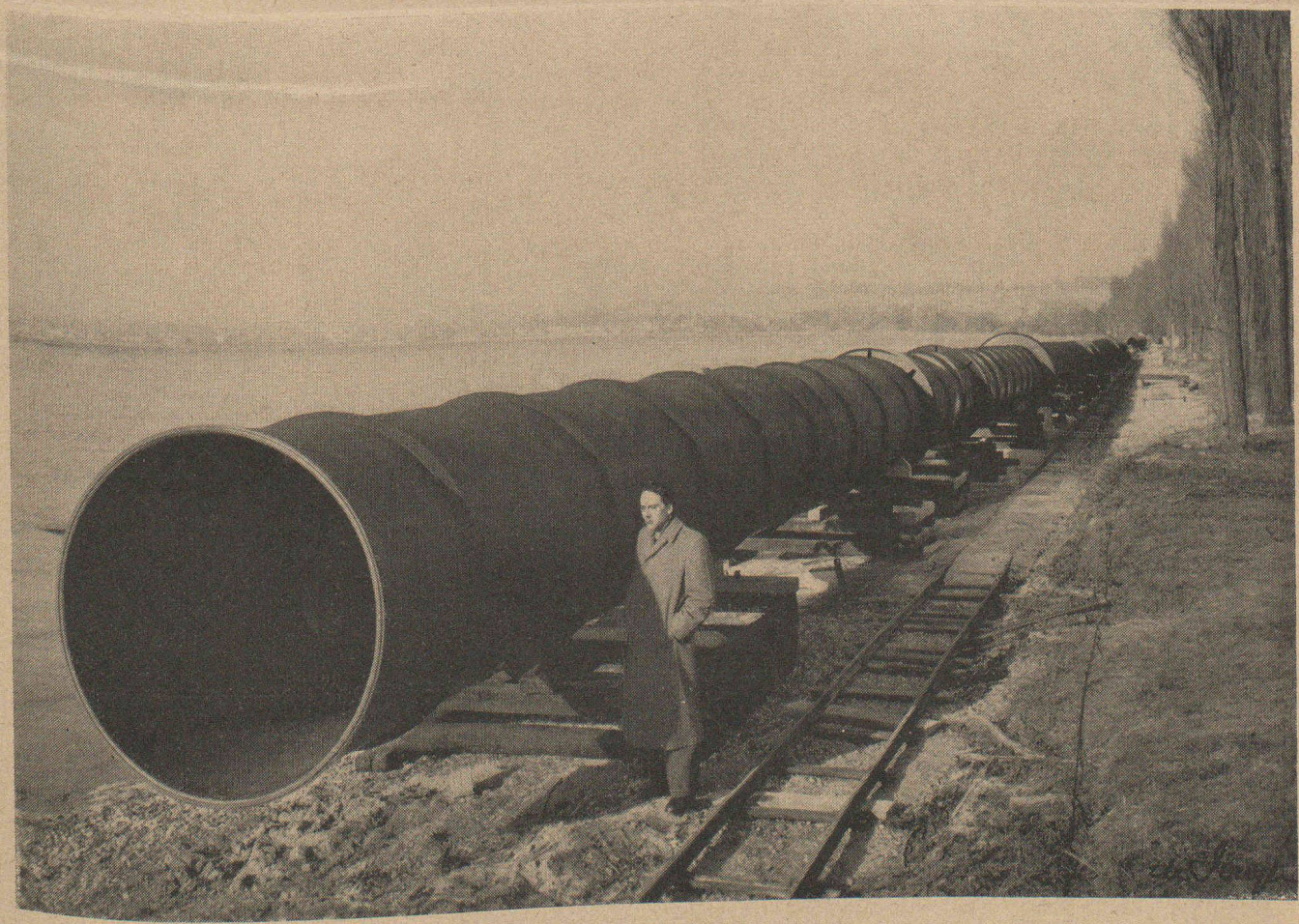
Conduite d'adduction diamètre 1600 mm. — Constructeur : ZWAHLEN & MAYR S. A., Lausanne Voir page 40 du présent numéro.
