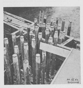
Fig. 12. — La forêt de pieux sous la moitié aval de la pile médiane, avant battage.
