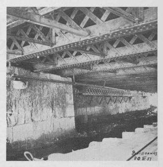
Fig. 3. — Vue par-dessous de la poutraison de l'ancien pont B. D. et l'ancienne culée rive gauche.
