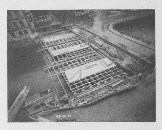
Fig. 10. — Construction du coffrage du tablier sur les anciennes poutres abaissées.
