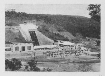
Fig. 5. — Centrale Bia. Chambre de mise en charge. Conduites forcées. Centrale et poste de transformation.
