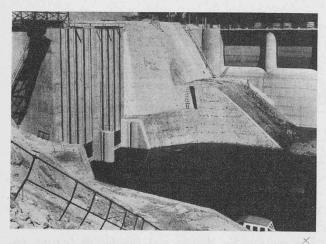
Fig. 7. — Centrale Delcommune. Evacuateur de crues et prise d'eau. Vue d'amont.
