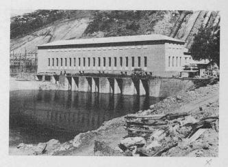
Fig. 8. — Centrale Delcommune. Centrale. Conduites forcées en montage.
