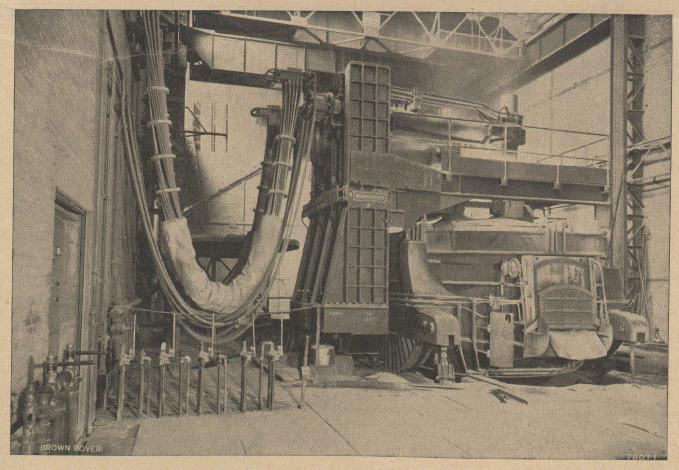
Four à arcs à voûte pivotante Brown Boveri pour chargement par benne, capacité 16 à 20 tonnes, vu de la plateforme de travail
