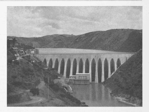
Fig. 2. — Le barrage de Pracana. Barrage à contreforts massifs, de  $60\,\mathrm{m}$  de hauteur, usine  $(2\times10\,000\,\mathrm{GV})$  et évacuateur de crues (puits vertical avec vanne cylindrique, et galerie horizontale :  $1650\,\mathrm{m}^3/\mathrm{sec}$ ).
