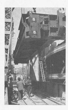
Fig. 8. — Une vanne du barrage en montage. A droite en bas, le panneau inférieur, déjà monté. On en distingue les deux poutres maîtresses en position horizontale. En haut, la poutre maîtresse du panneau supérieur, suspendue à deux portiques de montage (non visibles), quelques instants avant d'être placée dans sa position définitive.
