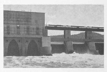
Fig. 9. — Aile droite du barrage à vannes, usine et canal de fuite. Seuls les panneaux supérieurs sont abaissés.
