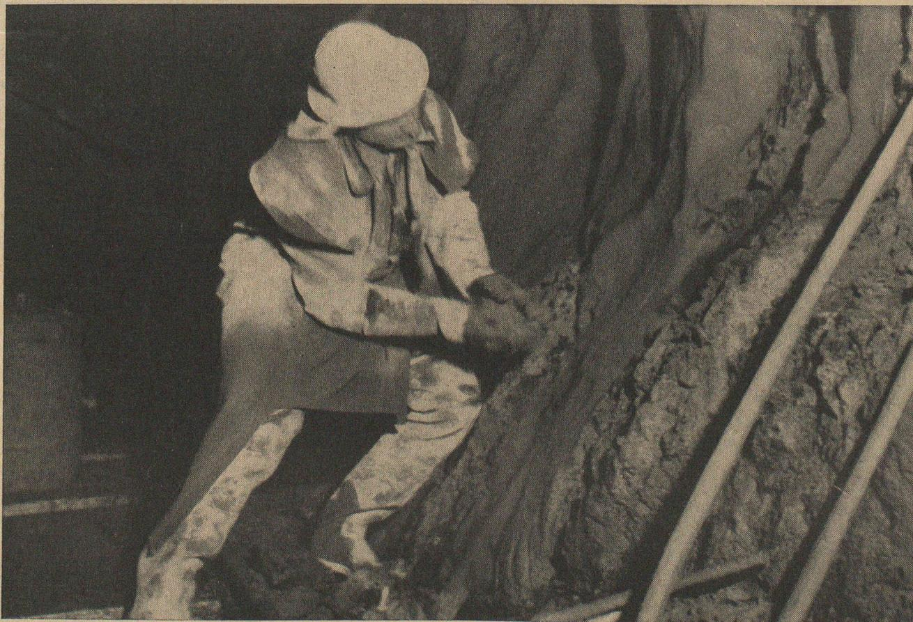
Usine hydro-électrique de la Maggia, étanchéité préalable de la conduite forcée de Verbano avec BARRA RAPIDE U.
