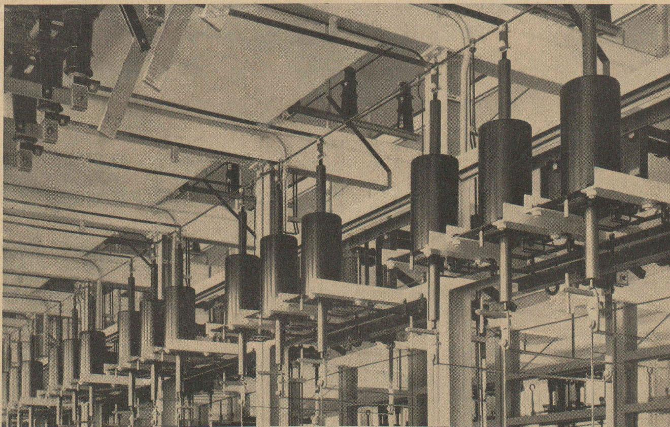
32 transformateurs de mesure d'intensité livrés par Landis & Gyr S. A. Zoug, pour la sous-station de Buchs du S. A. K. St-Gall.
