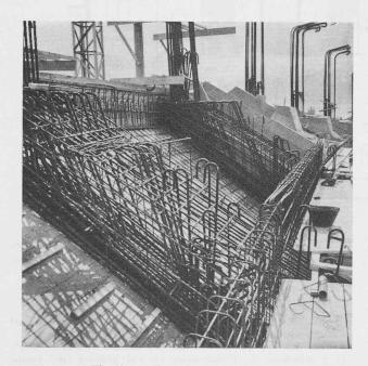
Fig. 8. — Armature des consoles.
