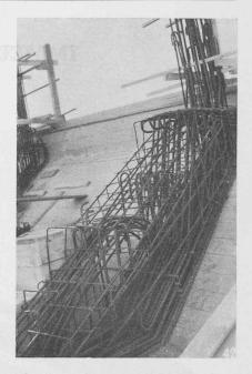
Fig. 5. — Armature d'une console.
