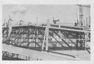
Fig. 7. — Armature des sommiers de la toiture.
