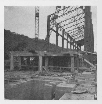
Fig. 6. - Hal du four, côté cuiseur : début montage.
