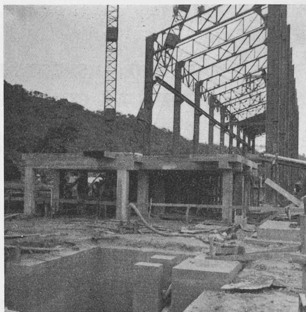
Fig. 6. — Hal du four, côté cuiseur : début montage.
