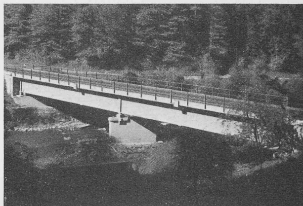
Fig. 18. — Pont-rail sur la Birse, à Bärschwil, ligne Delémont-Bâle. Poutre mixte continue acier-béton ; portées : 2 × 20,15 m. Exécution : Buss AG., Pratteln, 1944/45.
