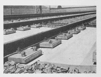
Fig. 5. — P. I. de Wichtrach, ligne Berne-Thoune, portée 3,80 m. Fixation de la voie sur la dalle en béton, à l'aide de semelles en caoutchouc et de selles métalliques.
