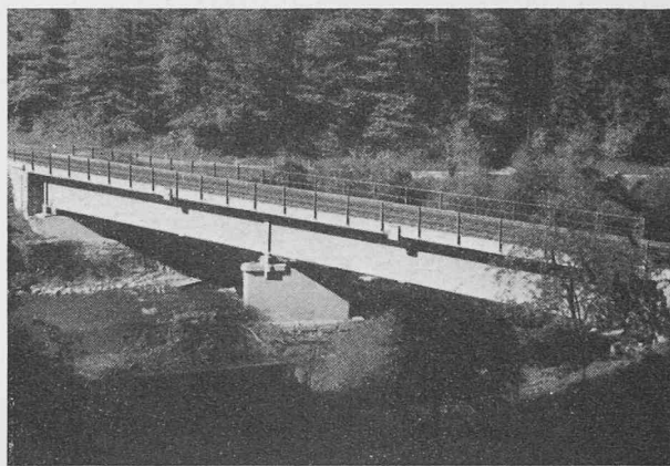
Fig. 18. — Pont-rail sur la Birse, à Bärschwil, ligne Delémont-Bâle. Poutre mixte continue acier-béton ; portées : 2 × 20,15 m. Exécution : Buss AG., Pratteln, 1944/45.
