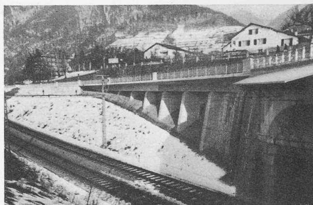
Fig. 12. — P. S. de Villeneuve. Elargissement et renforcement côté Lausanne.
