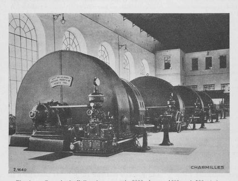
Fig. 1. — Centrale de Fully: 4 groupes de 3000 ch sous 1600 m à 500 t/min.
