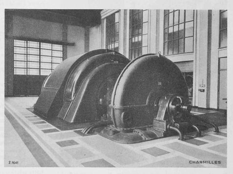
Fig. 11. — Centrale du Portillon? 1 groupe de 2×27 800 ch sous 1304,5 m à 500 t/min.
