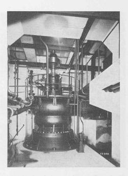
Fig. 3. — Pompe d'accumulation de la centrale de Rempen (Wägital).
