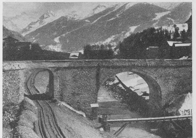
Fig. 7. — Le tunnel terminé.
