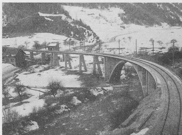
Fig. 3. — Le viaduc terminé.
