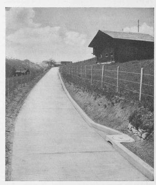
Fig. 4. — Dévestiture rurale à Rougemont. Dalle en béton de 14 cm d'épaisseur. Pente maximum, 7 º/0. Construction 1951.
