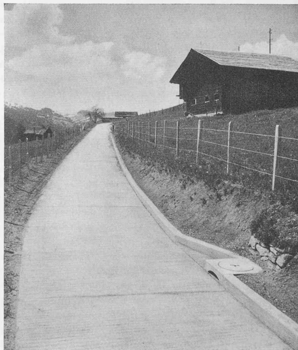
Fig. 4. — Dévestiture rurale à Rougemont. Dalle en béton de 14 cm d'épaisseur. Pente maximum, 7 %. Construction 1951.
