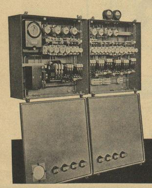
a créé et mis au point les coffrets de distribution normalisés pour montage apparent, livrables également en exécution étanche à la poussière et aux projections d'eau et pour montage encastré.
