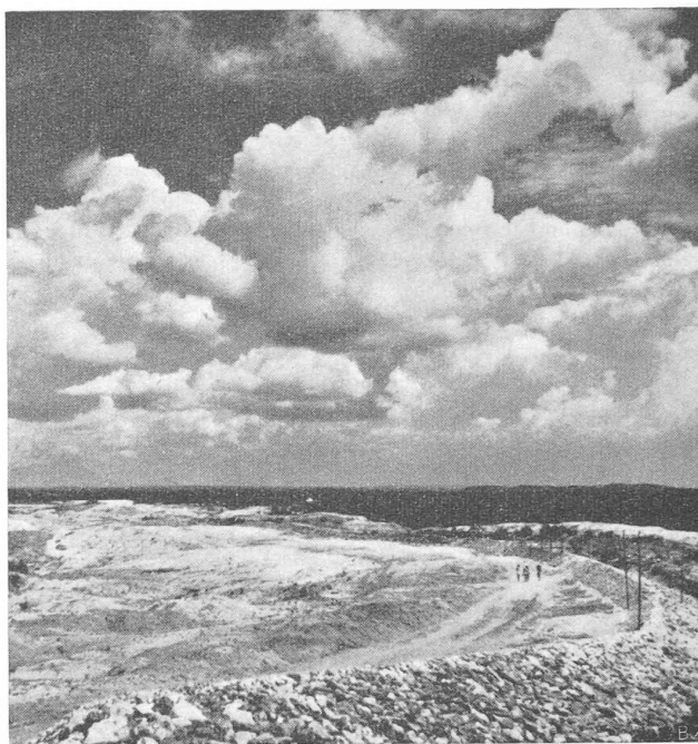
Fig. 15. — Barrage de Konar. Construction de la digue à ses débuts. Longueur totale : 4 km ; volume 4,6 Mio m 3 .
