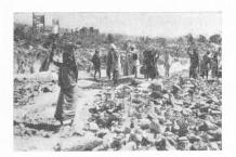
Fig. 16. — Barrage de Hirakud. Transports des matériaux d'excavation.
