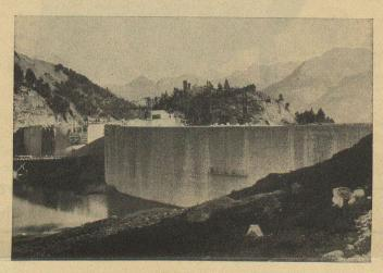
Barrage d'Aussois (Savoie) 75 000 m<sup>3</sup> de béton au Frioplast
