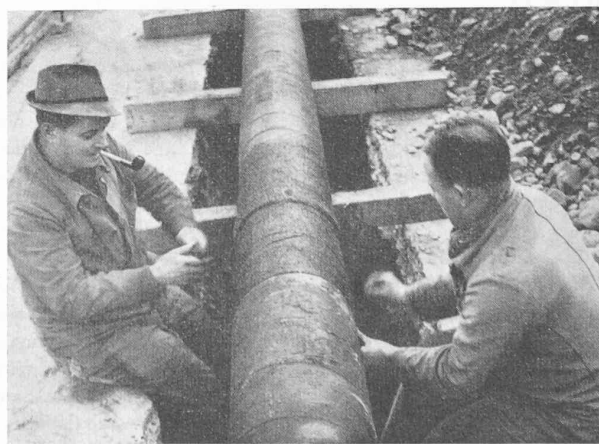
Fig. 3. — Isolation d'un joint soudé d'une conduite à gaz de la Ville de Zurich.
