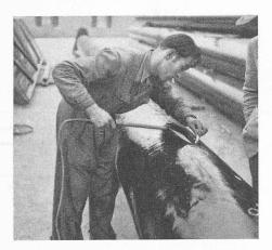
Fig. 4. — Contrôle électrique à haute tension d'une isolation « Vetro-Waberit ». Les endroits poreux décelés par l'arc sont marqués à la craie puis refondus au chalumeau. (Strassenbaumaterial A.-G., Berne).
