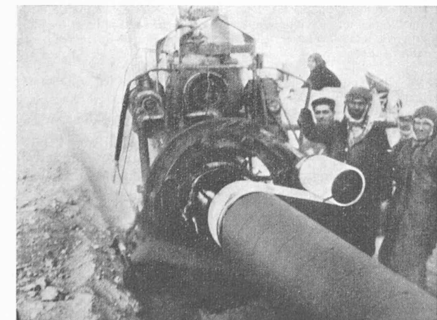
Fig. 1. — Isolation d'un pipe-line dans le Moyen-Orient. (Photo Fiberglass, Ltd).
