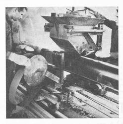
Fig. 2. — Isolation d'une conduite d'eau. (Zwahlen & Mayr, Lausanne).
