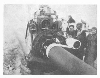
Fig. 1. — Isolation d'un pipe-line dans le Moyen-Orient.
