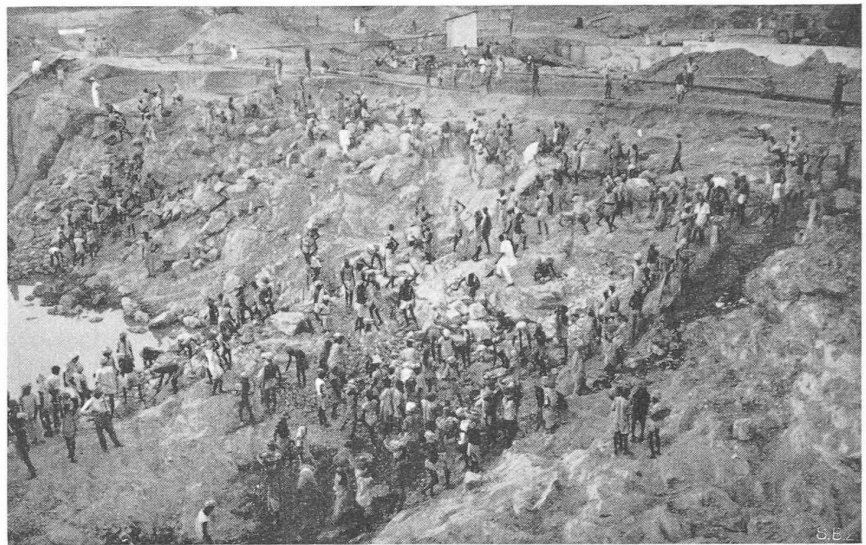
Fig. 8. — Excavation des fondations pour le barrage de Konar I (Damodar Valley Authority).
