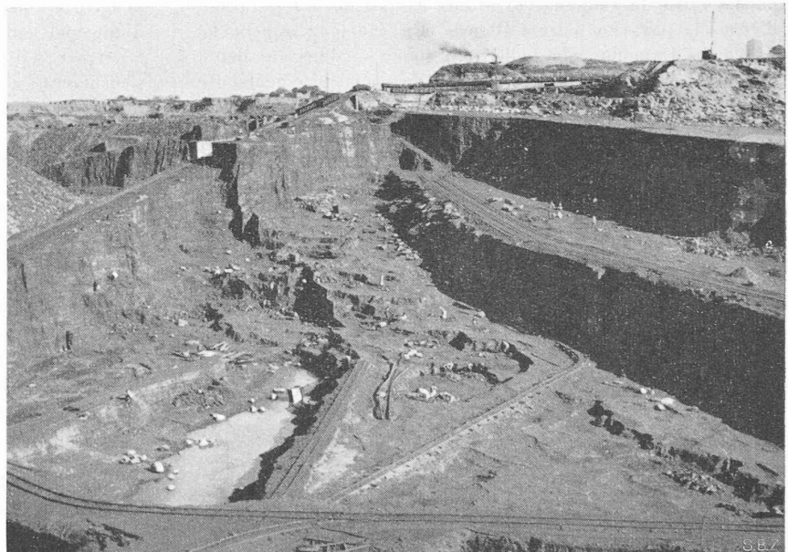
Fig. 9. — Exploitation à l'air libre d'une couche de charbon de 50 m d'épaisseur dans une mine de Bokaro, vallée du Damodar, Etat de Bihar.
