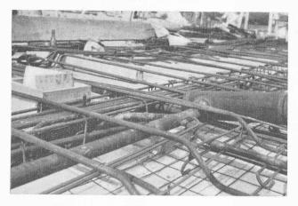
Fig. 1. — Détail des armatures et serpentins. En vue, une bouteille d'air.
