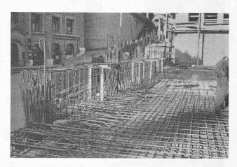
Fig. 2. — Détail de l'armature de la dalle et des piliers (attente).
