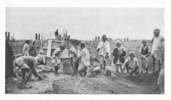
Fig. 3. — Barrage de Nangal. Fabrication du béton.
