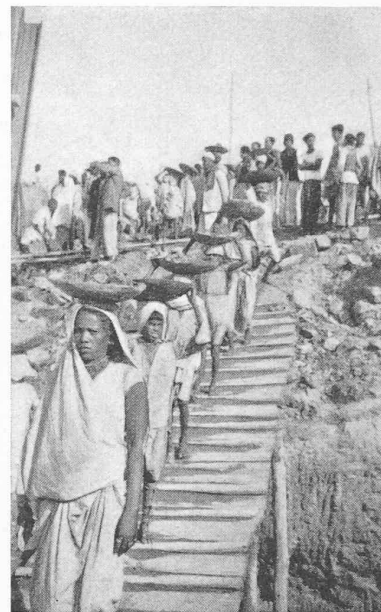
Fig. 4. — Barrage de Tilaya. (Damodar Valley Corporation). Transport du béton.
