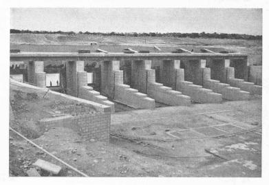
Fig. 7. — Barrage de Nangal. Ouvrage d'entrée du canal de dérivation.
