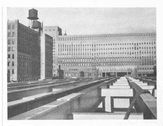
Fig. 1. — Chicago. Entrée dans la ville d'une autostrade sans croisements. Au premier plan poutres métalliques du tablier; en arrière, bureau des postes, traversé par l'autostrade et construit lui-même sur la gare.
