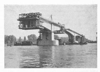
Fig. 3. — Le bétonnage se fait par éléments de 3 mètres symétriquement par rapport à la pile.
