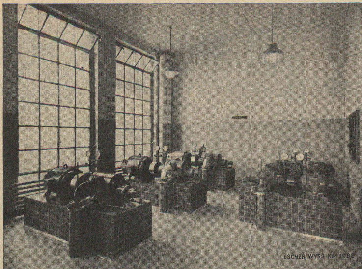
5 compresseurs « RO TASCO » pour la réfrigération des entrepôts frigorifiques
