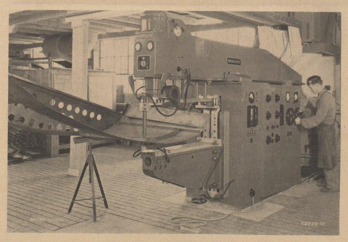
Machine à souder par points et à la molette Brown Boveri, la plus grande qui ait été construite jusqu'ici. Sa puissance maximum est de 1000 kVA, la longueur utile maximum des bras de 1500 mm et l'effort maximum de pression des électrodes de 3000 kg.
