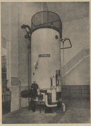
Chaudière électrique, 4500 kW, 16 000 V, 10 kg/cm²
