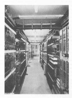
Fig. 11. — Genève-Cornavin, Poste I: Vue du local à relais. On voit à droite, au premier plan, des jeux de relais de commande d'aiguille, à connecteurs.
