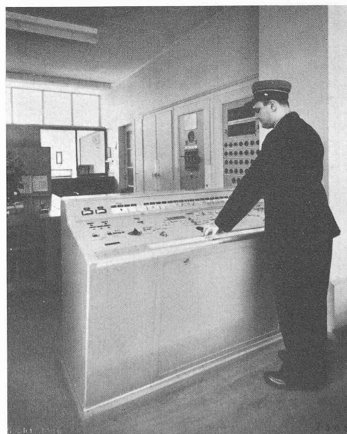
Fig. 3. — Le Locle-Ville : Pupitre de commande Hasler et bureau de gare.
