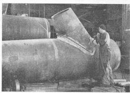
Fig. 25. — Culotte de la conduite au droit du groupe I. — Préparation pour le soudage.
