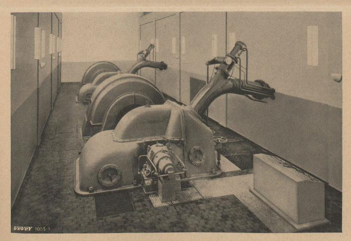
Vue de la salle des machines de la Centrale de Sassello des Forces motrices de la Calancasca S. A. Les deux turbines de 14130 ch chacune ont été livrées, avec leurs régulateurs, par les Ateliers de Constructions Mécaniques de Vevey S. A.
