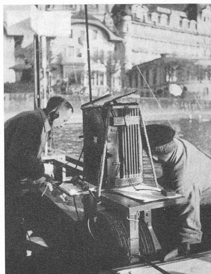
Fig. 14. — Chef d'équipe (à gauche) en train de faire la lecture au câble de sonde. Au-dessus de lui le signal abaissé.
