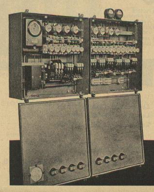
les coffrets de distribution normalisés pour montage apparent, livrables également en exécution étanche à la poussière et aux projections d'eau et pour montage encastré.
